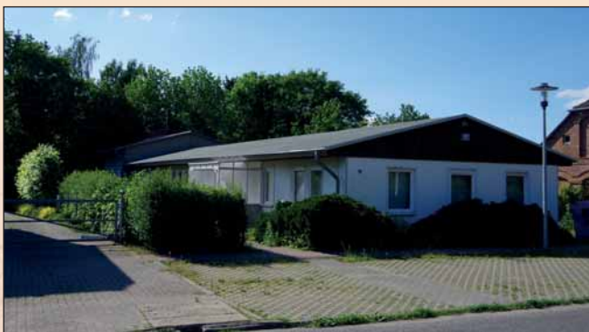
Das ehemaliges Verwaltungsgebäude der KAP, nach 1990 Sitz der Luisenhof eG.
