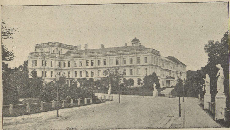
Schloß in Neustrelitz vor dem Umbau.
