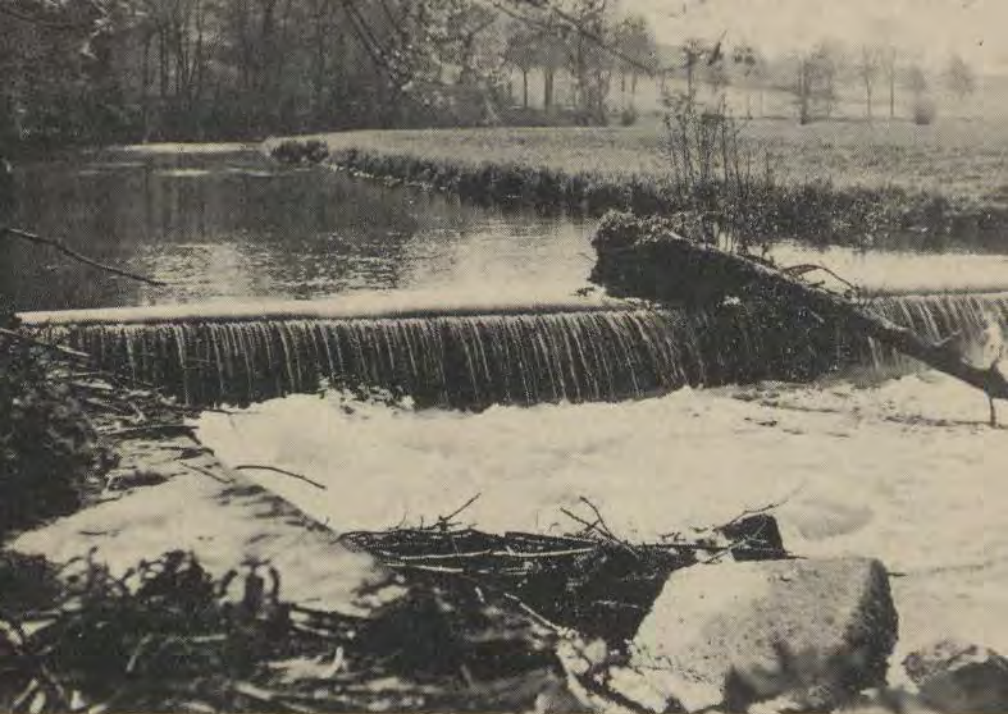
Abb. 1 Die Terrassenbildung zur Regulierung des Flußlaufes erschweren bzw. verhindern Fischwanderungen und führen zur Isolierung von Fortpflanzungsgemeinschaften Foto: W. Fiedler
