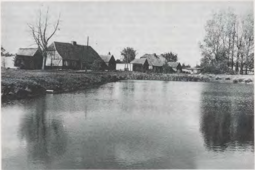
Abb. 2: Dorfweiher Ihlenfeld – zusätzlich zu den üblichen Negativfaktoren (Einleitung von Abwässern und Wassergeflügel) wurde durch Planierarbeiten am Steilufer geschaffen. Foto: H. Nehring
