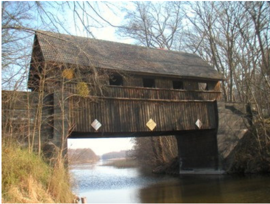
Wildhof Bridge, nr. Ahrensberg, Mecklenburg-Vorpommern.
