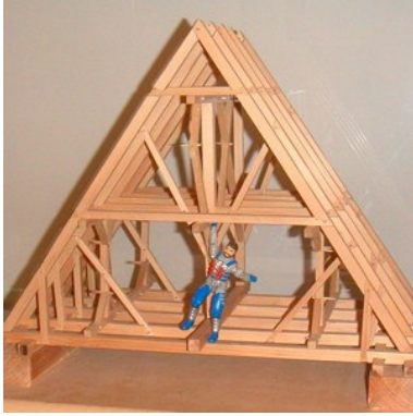
10. Pöls (A) - Chordach
